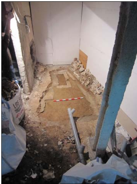
FOTO 3. Vista del sector 2 just abans d'iniciar-se l'excavació arqueològica.
