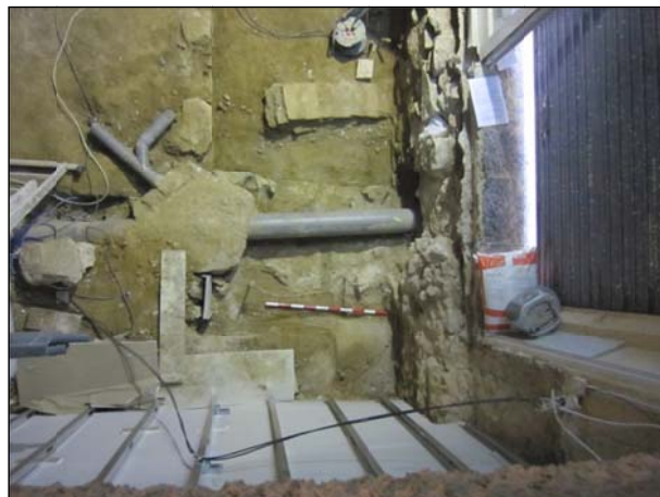
FOTO 22. Vista zenital de la banda nord del sector 1 on apareix, sota el desguàs de PVC, les restes de la fonamentació ue-31.
