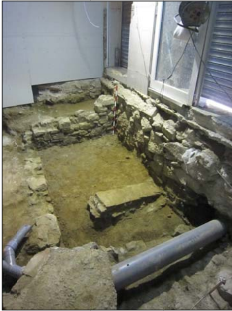
FOTO 5. Vista del dipòsit ue-02 adossat a la fonamentació de la façana principal.
