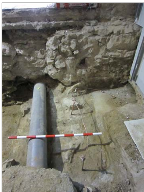
FOTO 23. Vista frontal de la paret de tancament nord del dipòsit ue-02 (esquerre), tub de PVC (centre), fonament ue-41 (centre-dreta), i recalç de formigó (dreta).
