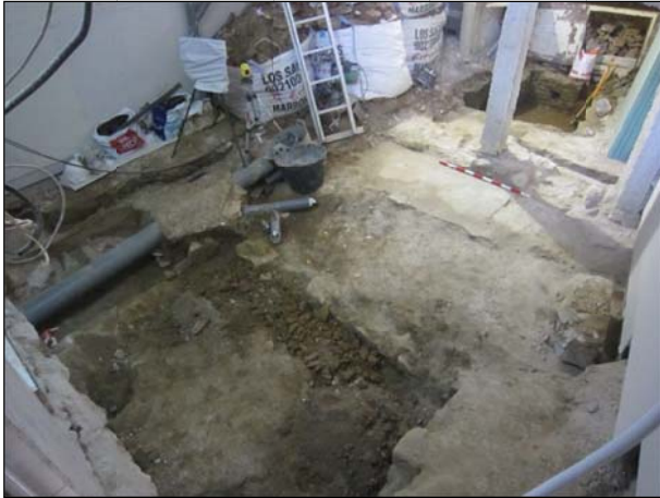
FOTO 1. Vista dels dos sectors que conformen l'interior del local.
